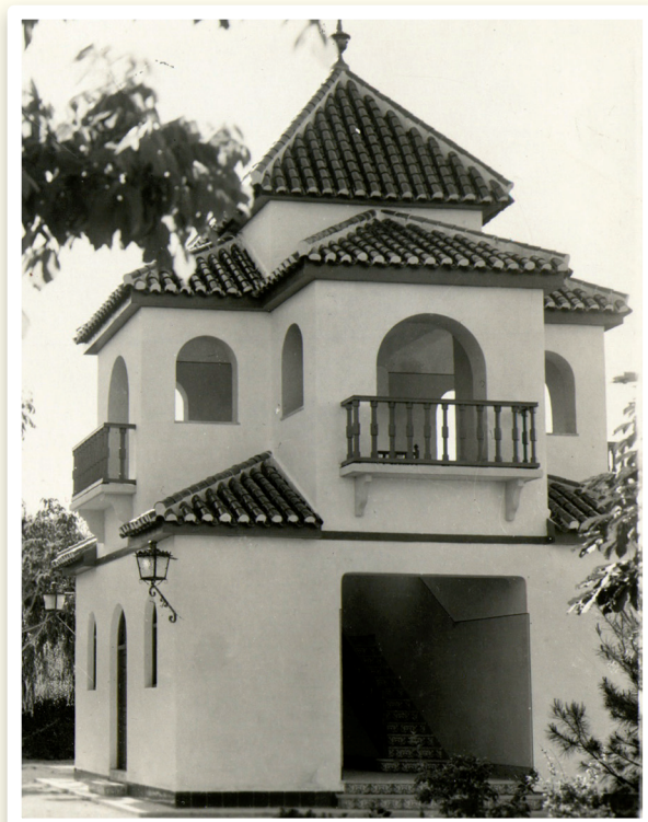
■ El edificio de los aseos públicos y caseta de aperos para los jardineros. (Foto: Juan Antonio Avilés).
